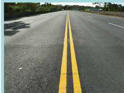
0+500處再生瀝青混凝土
