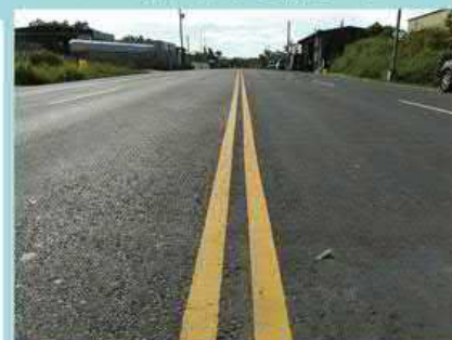
0+350處氧化碓瀝青混凝土
