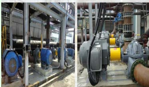
冷卻水泵汰換改善
