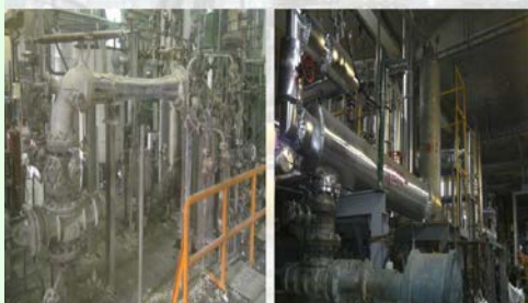
四段真空Steam Jet改為EG Jet
