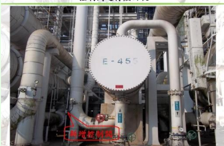
乙炔反應器出口冷卻器E-455增設旁路管線及控制閥進行熱回收
