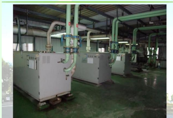
東側低效率冰水機(1.2kW/RT)備用
