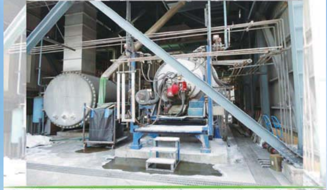
增設蒸汽鍋爐燃燒廢液回收廢熱《98.5~99.5》
