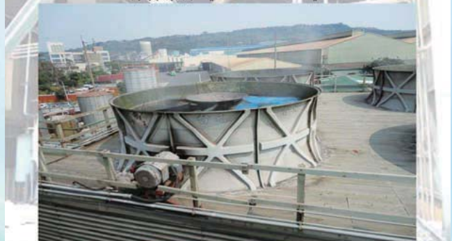
將三組冷卻水塔鋁合金材質風扇更換成HUDSON第二代FRP材質葉片《99.05~99.10》
