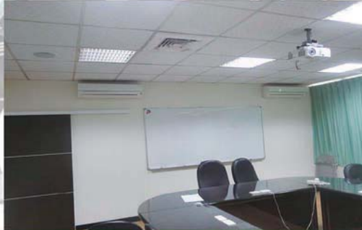
將辦公室2F空調系統，更改為變頻節能分離式冷氣，降低空調系統耗電量《99.7》
