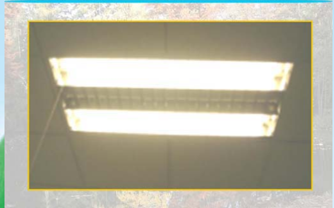
辦公區省電T5燈管取代較耗电T8燈管，降低CO 2 排放
