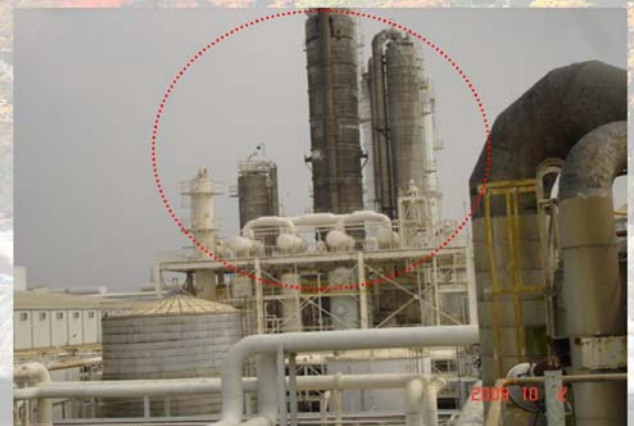
蒸餾塔在製程許可之下降底回流比以達節能減碳。
