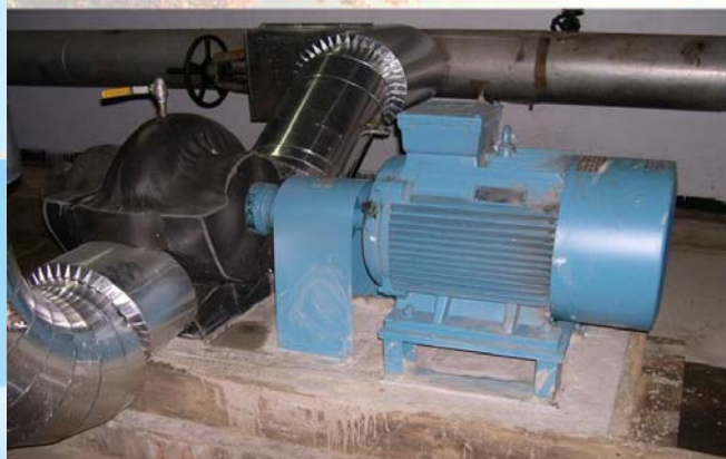
各區冷凍水系統更換高效率泵浦及加裝變頻器(合計8台)
