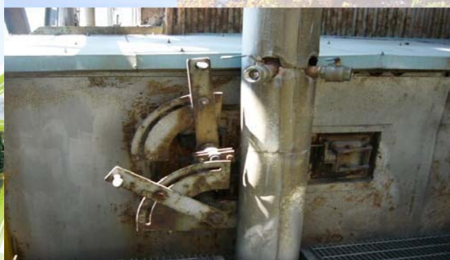
鍋爐粉煤管作等動量取樣，分析粉煤細度
