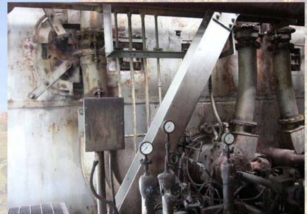
調節粉煤二次、三次風門使火焰燃燒長度在一定區域
