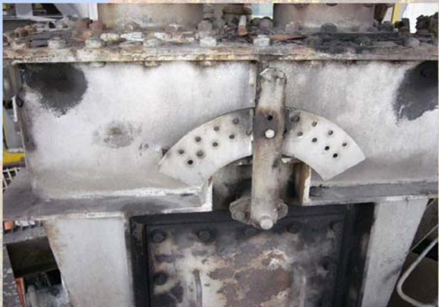
調節粉煤管分配器使管內粉煤分流均勻
