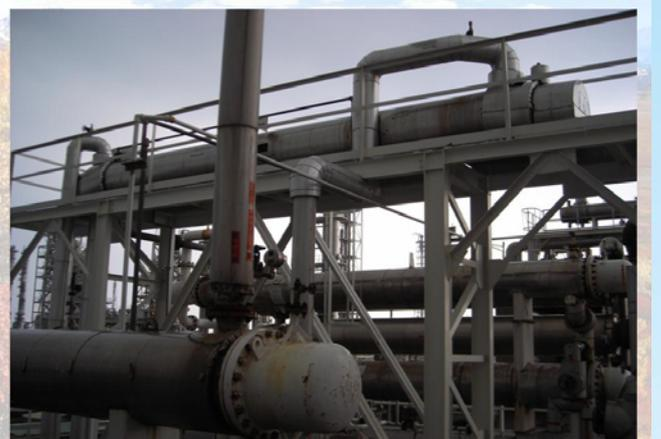
低溫熱水經各個熱能回收器加熱後溫度升高，此高溫熱水則做為低溫製程再沸器之熱源。
