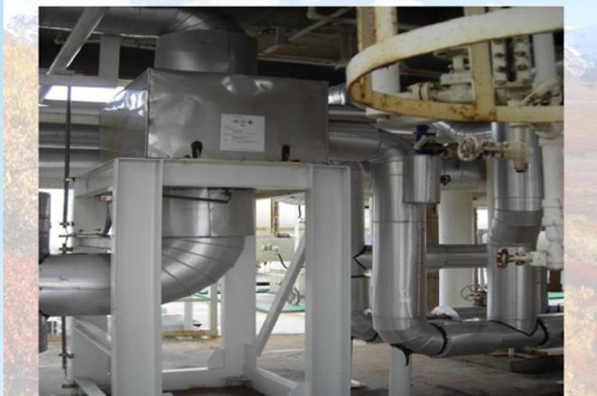
E-5431 熱能回收器，可回收製程熱能0.30MMKcal/hr。
