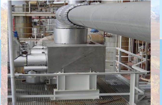
T-2251B 高效率熱能回收器，可回收製程熱能1.67MMKcal/hr。
