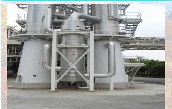
SBA的製造採用間接水合法。對反應區而言，硫酸為反應物亦是催化劑，增設壺座反應器，相同產能下反應時間增加，催化劑的使用量降低，進而減少後續硫酸濃縮的能耗量。
