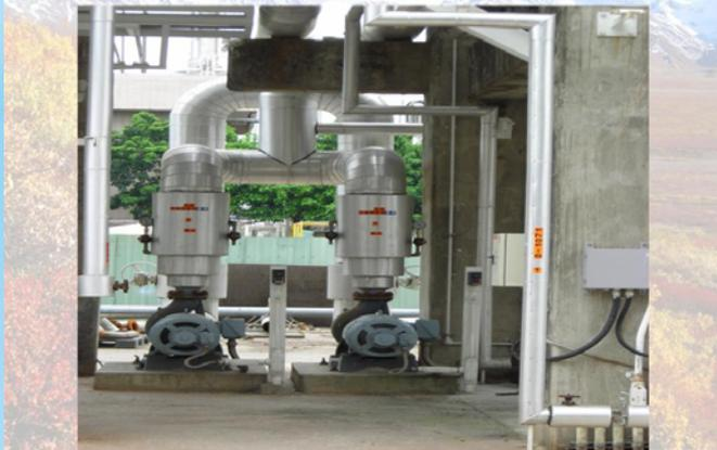
T-2251A 高效率熱能回收器，可回收製程熱能2.33 MMKcal/hr。
