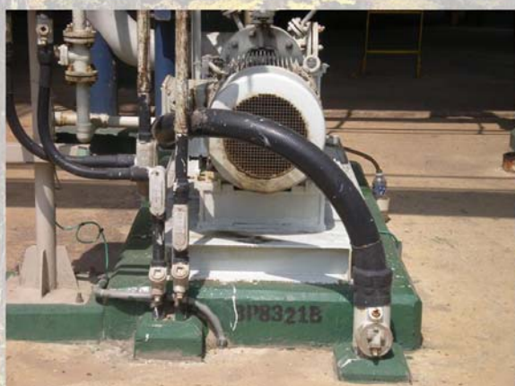
離心式壓縮機冷凝水輸出泵浦改善
