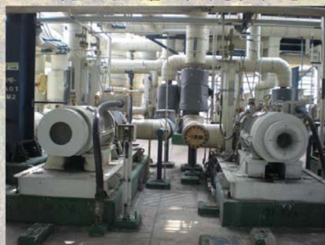
高壓/低壓鍋爐給水補充泵浦改善
