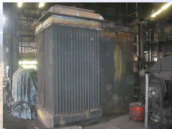
加熱爐更新熱交換器，減少燃料油耗用。
