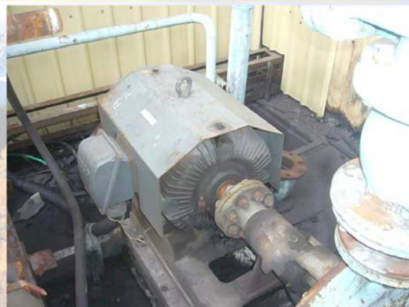
粗軋冷卻水更換高效率馬達，減少電力耗用。
