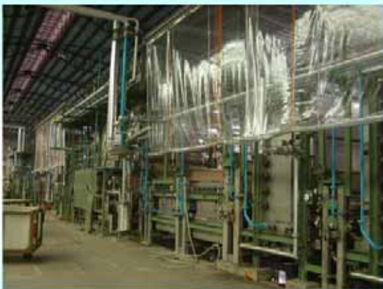
新購節能省水精練漂白機，並移設中壢廠集中生產，提高能源效益。
