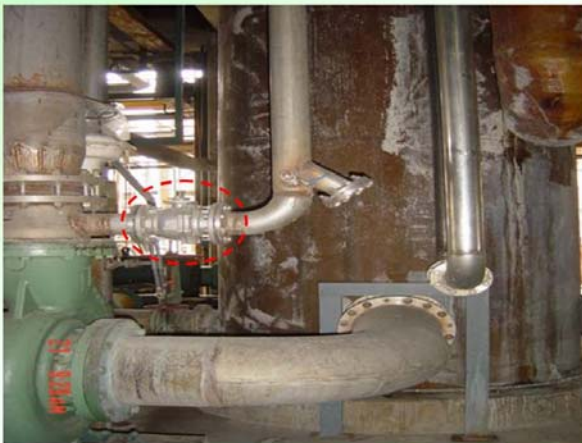
O/E送D1/C淋洗泵改插管停用泵改善
