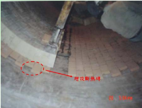
苛化石灰窯內層增設斷熱磚節能改善
