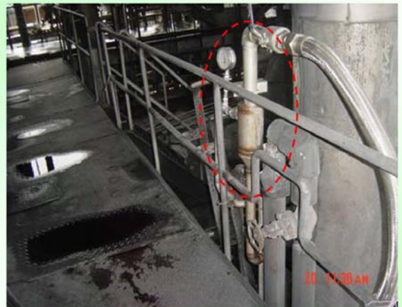
回收鍋爐排出口噴散由蒸汽改為空氣
