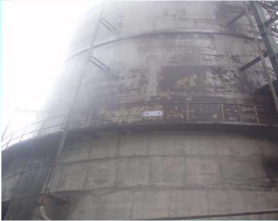
煤灰儲存設施
