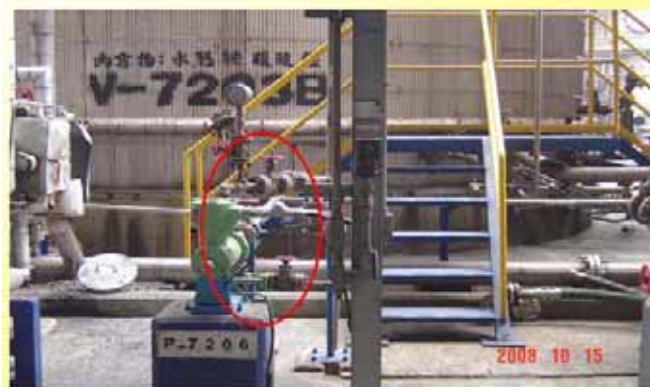
原泵至焚化爐之稀硫酸銨液部份加以回收處理， 減少濃縮所需蒸汽用量及焚化燃油耗用
