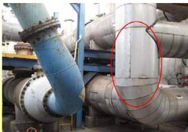
將原2座串聯之換熱器改為並聯方式，降低空壓機之輸 出壓力，節省電能消耗
