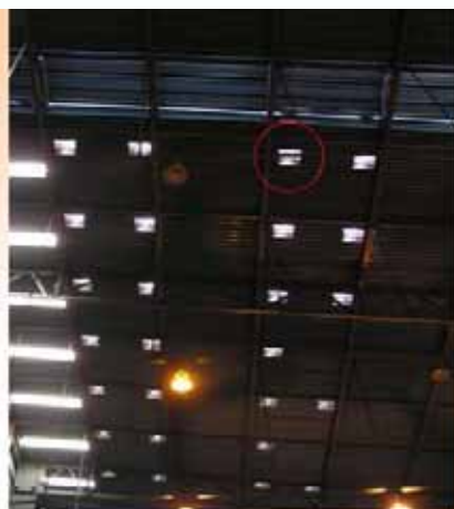
#2連續退火線採用無動力式屋頂排風扇，提升廠房通風
