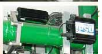
在冰水主機冷凝器冷卻水管進口，加裝 電場式水垢處理器 ，可以防止水中鈣鎂離子附著在冷凝器銅管壁上，因積垢而造成冰水機高壓升、高耗電，以及處理水垢問題等。
