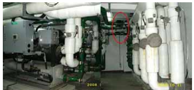
在冰水主機冷凝器冷卻水管進口，加裝 電場式水垢處理器 ，可以防止水中鈣鎂離子附著在冷凝器銅管壁上，因積垢而造成冰水機高壓升、高耗電，以及處理水垢問題等。
