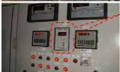
氧氣分析儀顯示器 加熱爐加裝氧氣分析 儀，可更精準量測爐 內廢煙氣（Flue Gas） 含氧量，準確控制及 調整加熱爐燃燒區之 Air/Fuel Ratio，達到 完全燃燒節約能源 目的。
