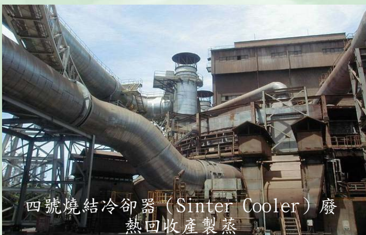
區域能源整合 - 16 吋外售蒸汽管線
