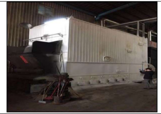
鍋爐外壁改善後 40~80°C
