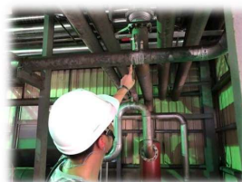
空壓系統管路洩漏檢查
