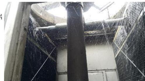
冷卻水塔額定能力(RT) ≙ 冰水主機額定能力(RT) X 1.3~1.5倍
