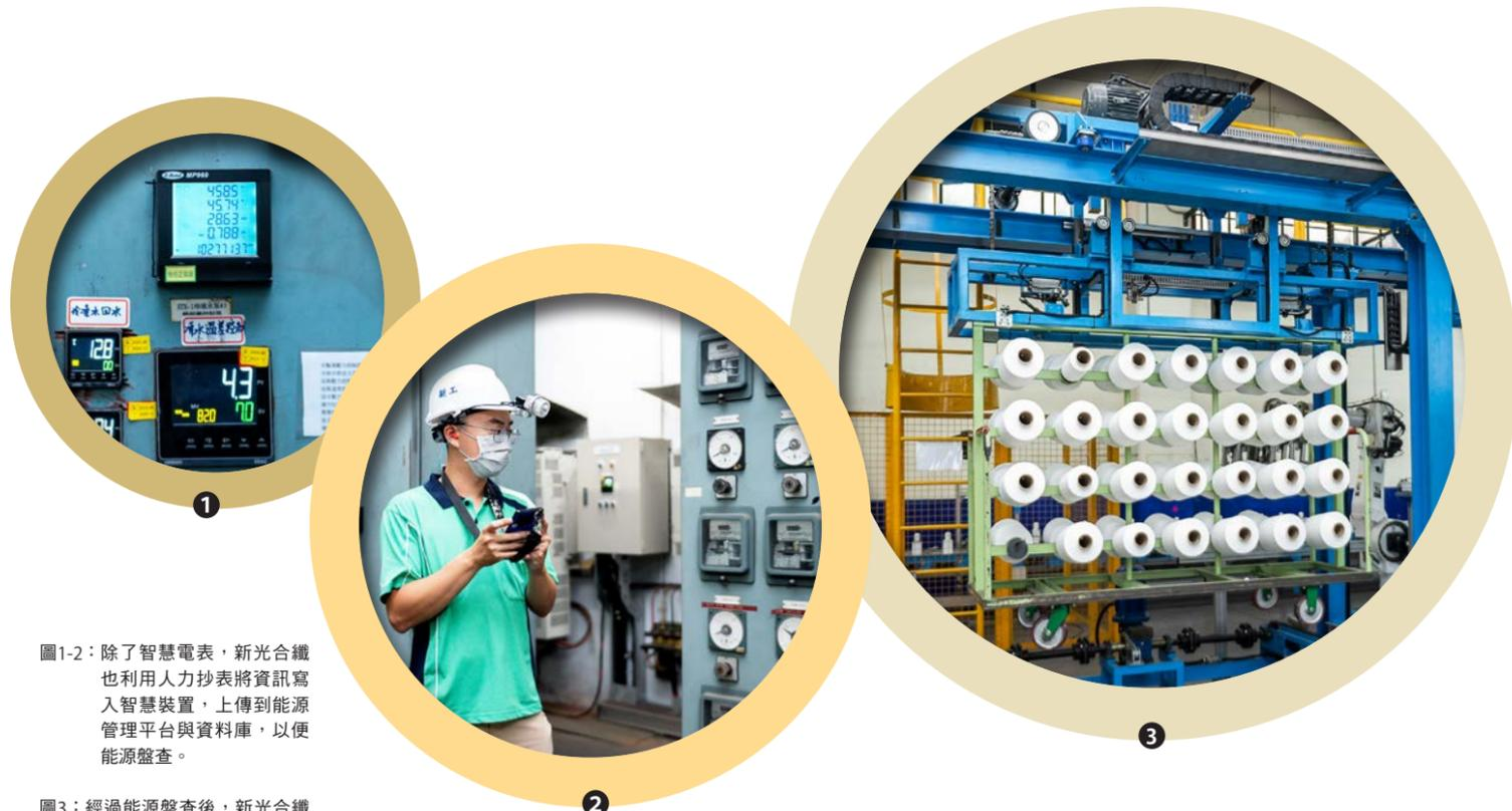
圖1-2：除了智慧電表，新光合纖也利用人力抄表將資訊寫入智慧裝置，上傳到能源管理平台與資料庫，以便能源盤查。
