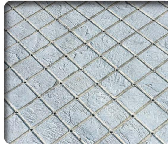
JW生態環保鋪面，小洞猶如地表的毛細孔，能回收雨水循環使用。
