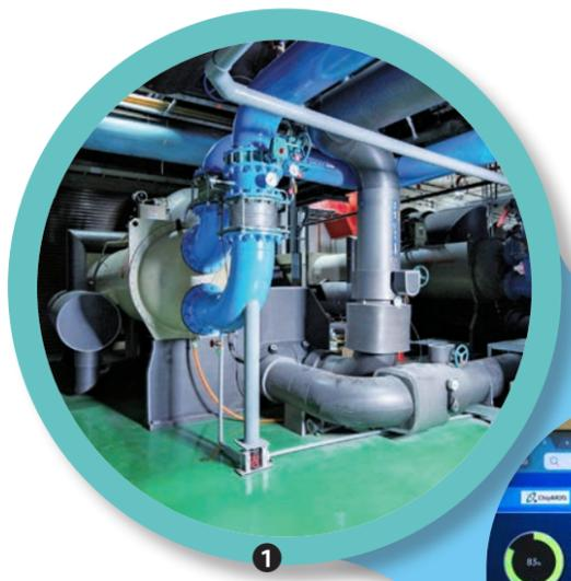
圖1：南茂導入軟體監控系統，可調節每一台冰水主機的供應量，以達到最佳能源使用效率。
