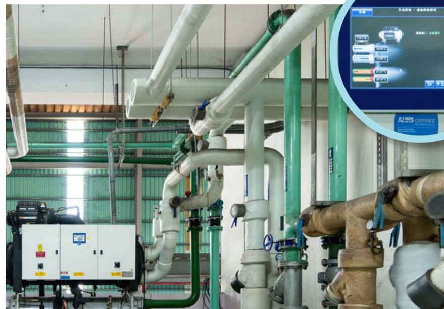
高效能磁懸浮冰水機，其冷卻系統共管可提高能源使用效率。
