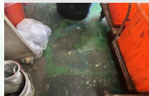
廢水區地鋪面破損
