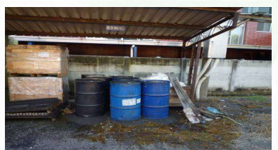
未設置防護措施、鋪面有入滲之虞
