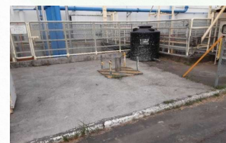
廢水槽旁地下水自主監測井
