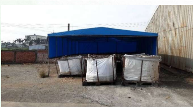
重金屬污泥無完整遮蔽、鋪面破損
