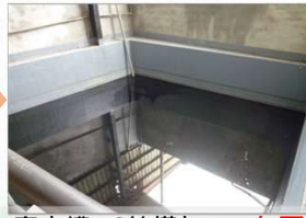
廢水槽RC結構加FRP包覆 定期檢視維護防洩漏
