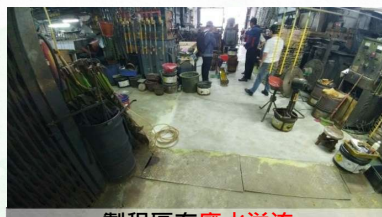
製程區有廢水溢流
