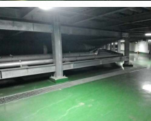
地下共同管溝偵測
