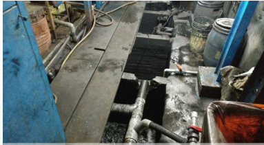
原廢水處理槽為地下式
