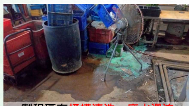
製程區有桶槽清洗、廢水漫流
