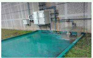
廢水/廢液輸送管線地上化、周遭鋪設FRP、設防溢堤及流量監測
