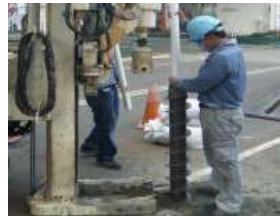
監測井設置及土壤採樣
