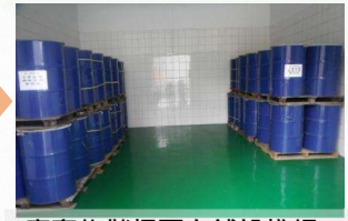
廢棄物儲桶下方鋪設棧板， 廢棄物區EPOXY塗料鋪面
