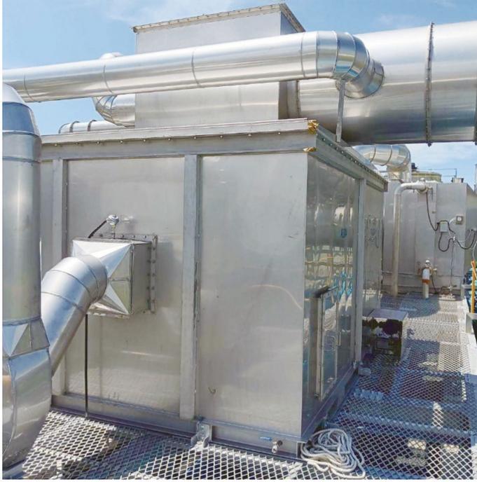
圖 2 沸石轉輪吸脫附系統外觀圖
