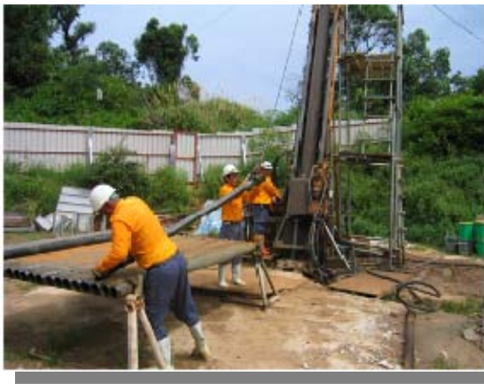
圖 4-8 現場地質鑽鑿作業
