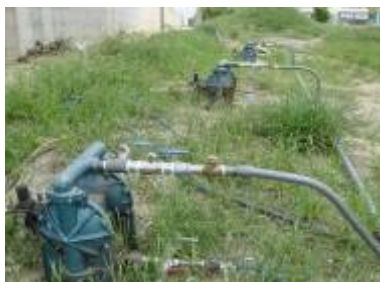
圖 3-12 浮油(泵)回收作業
