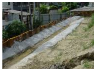
圖 3-13 鋼板樁阻絕措施
