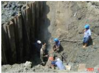
圖 3-10 漏源(管線)搶修
