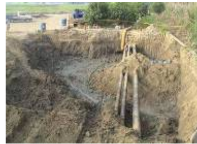
圖 3-11 油污染土壤移除
