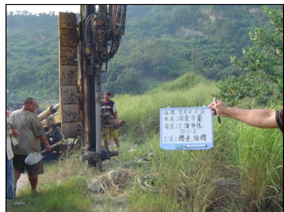
圖 4-9 鑽堡現場操作狀況
