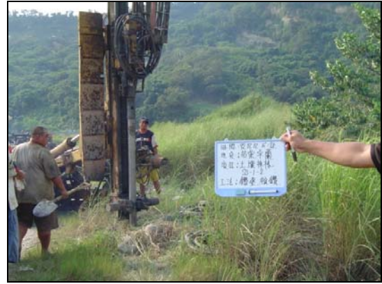
圖 4-9 鑽井現場操作狀況
