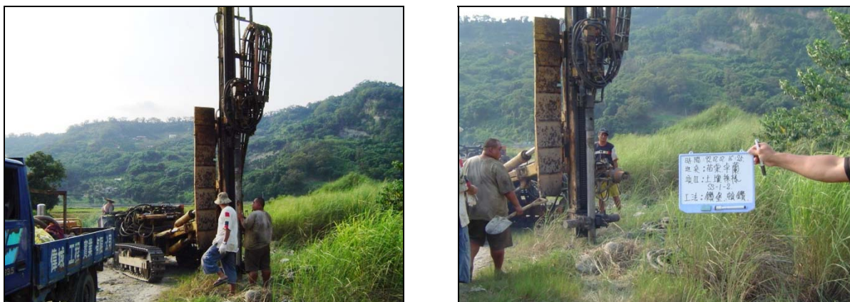
圖 4-9 鑽堡現場操作狀況
