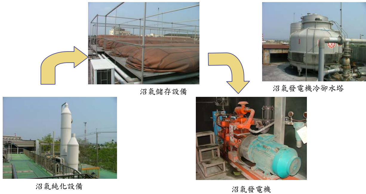
圖 5 廢水沼氣發電系統流程設備
