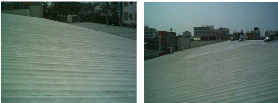
圖 4 某產業鐵皮屋頂塗佈降溫改善案例(施工後 5 年)
