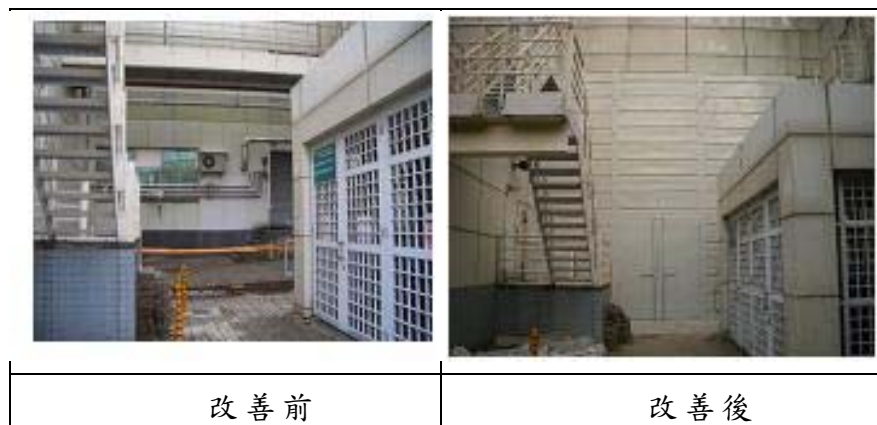
圖 3 VOCs 設備區噪音改善工程
