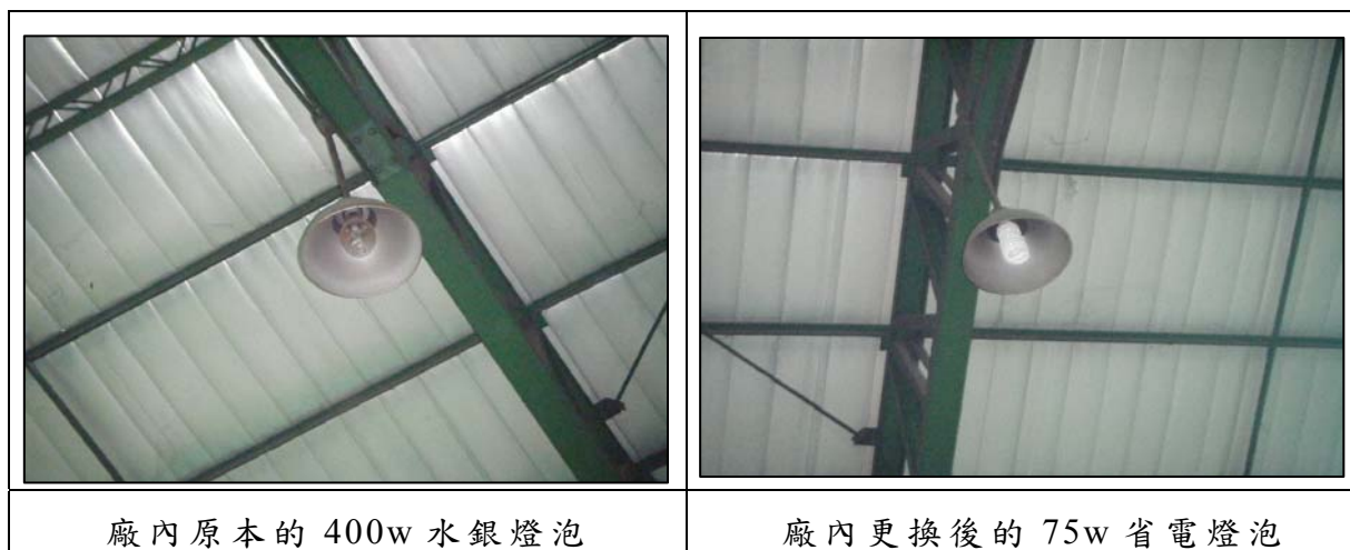
圖 1 工廠內水銀燈泡更換為省電燈泡
