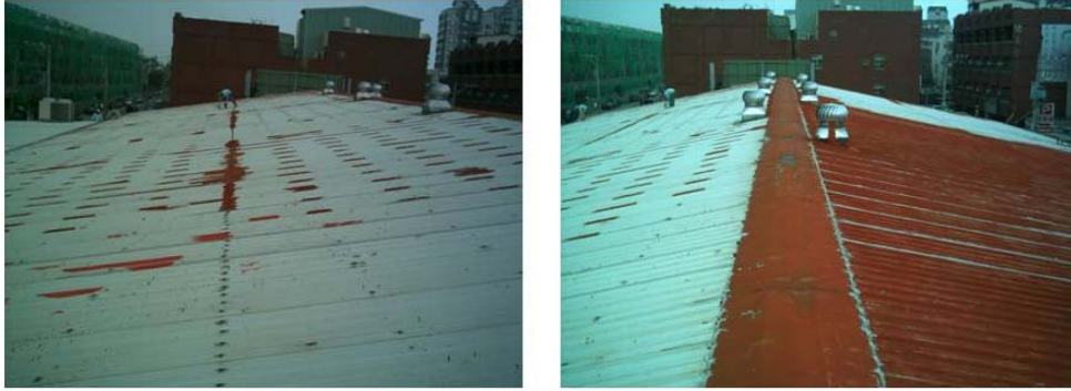
圖 2 某產業鐵皮屋頂塗佈降溫改善案例(施工前)
