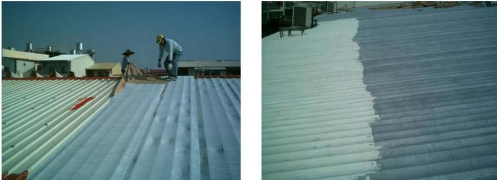
圖 3 某產業鐵皮屋頂塗佈降溫改善案例(施工中)
