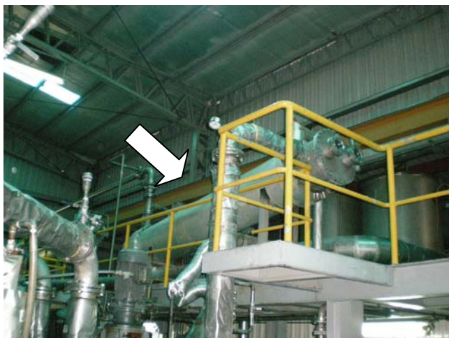
圖 1 室溫冷凝回收器
