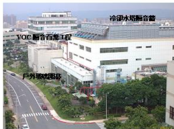
圖 2 廠區歷年噪音防制工程
