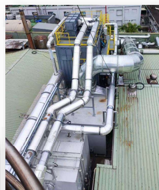
現場安裝狀況
