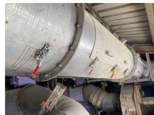
廢氣風管更新改善清掃口
