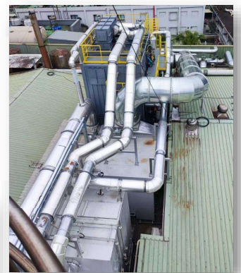
現場安裝狀況
