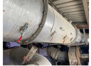
廢氣風管更新改善清掃口
