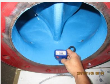
5.流道低摩擦陶瓷基材料施工
