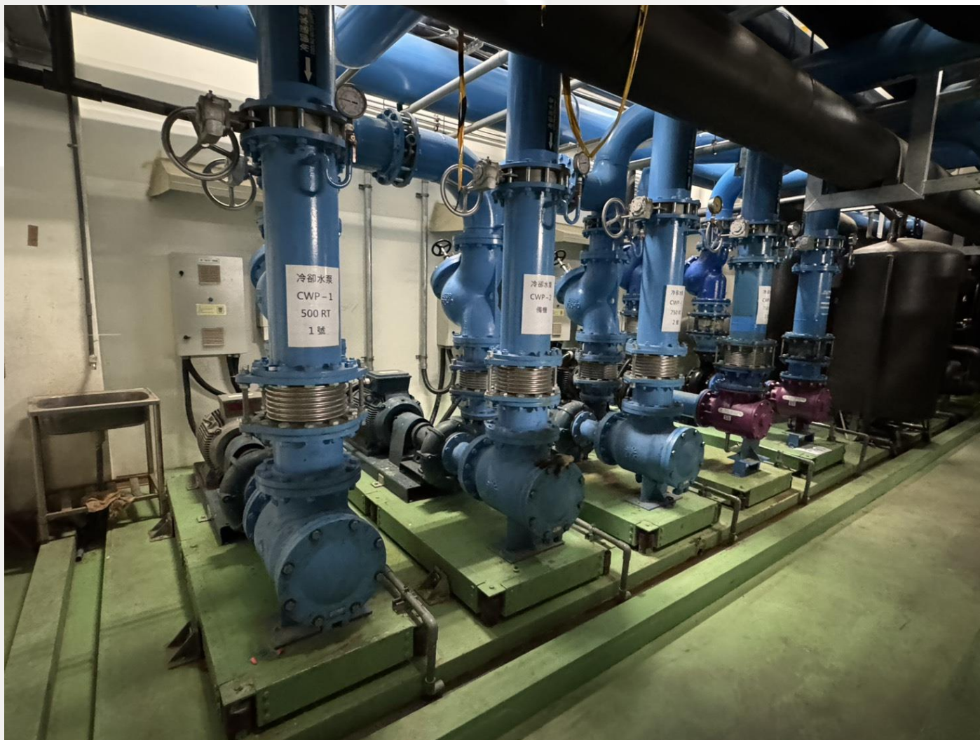
CWP01 舊有60HP 泵浦 效能量測
