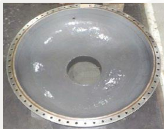
冰水主機熱交換器修補保護
